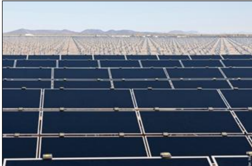
Agua Caliente Solar Plant, 290 MW AC
