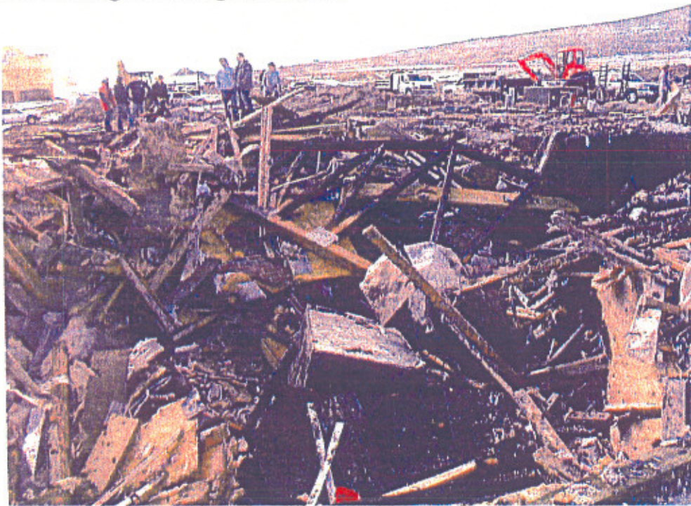
#19 Standing N.E. looking S.W., 02/07/07
